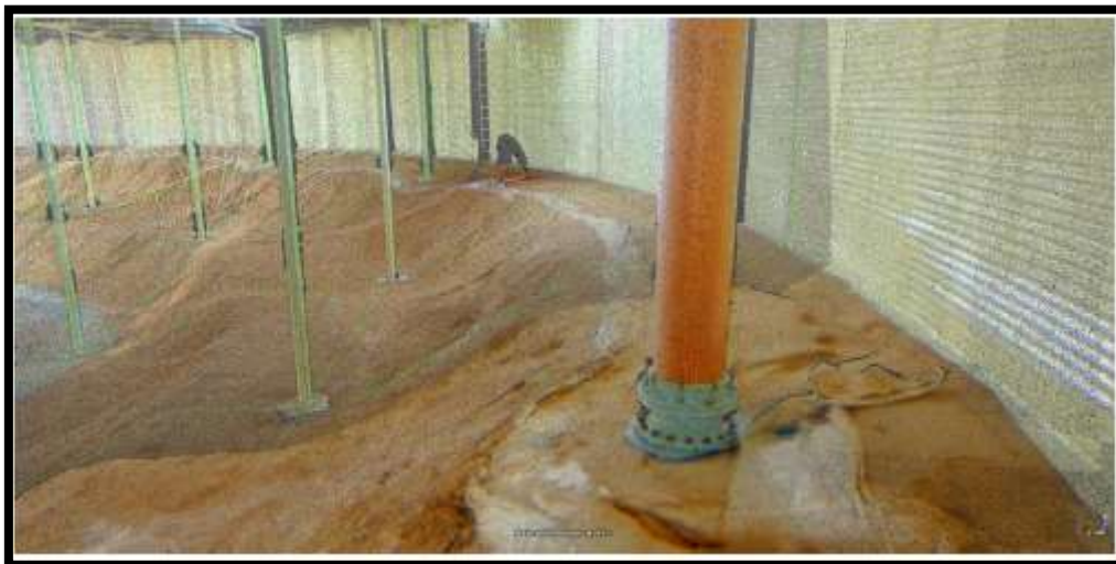
Detalle interior y vaso de los depósitos. Modelo LIDAR 1 .
